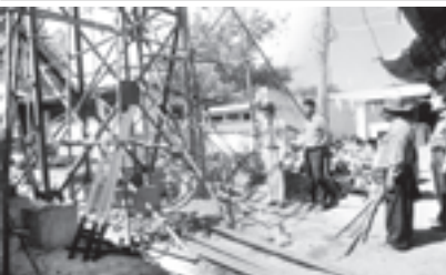
တောင်တွင်းကြီးမြို့နယ် မြို့မဈေးကြီးအတွင်း မီးသတ်ရေးစင်ဆောက်လုပ်ခြင်းလုပ်ငန်းခွင်သို့ မကျွေးတိုင်းဒေသကြီး စည်ပင်သာယာရေးအဖွဲ့ ဒုတိယအင်ဂျင်နီယာမှူးကြီး ဦးလင်းမိုးထိုက် ဖေဖော်ဝါရီ ၅ ရက်က ကွင်းဆင်းစစ်ဆေးရာ အမှုဆောင်အရာရှိ ဦးအောင်ပြီးကျော်နှင့် တာဝန်ခံအင်ဂျင်နီယာ ဦးနိုင်မြင့်မောင်တို့ ရှင်းလင်းတင်ပြကြသည်။ (မြို့နယ်စည်ပင်)
