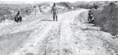
မူဆယ်မြို့နယ် စည်ပင်သာယာရေးအဖွဲ့မှ လက်ထောက်အင်ဂျင်နီယာ ဦးခင်မောင်တို့နှင့်အဖွဲ့ ဆောင်ရွက်လျက်ရှိသော မန့်ဇောင်ခေါင်-မန့်ပြီး-ဟိုက်နံ ကျေးလက်မြေသားလမ်း ဆောင်ရွက်ပြီးနောက် ဗဟိုဌာနက အမှုဆောင်အရာရှိ ဦးသင်းစိုင့် နှင့် တာဝန်ခံအင်ဂျင်နီယာ ဦးကျွေးလွန်စိုးတို့ ကွင်းဆင်းကြီးကြပ်စဉ်၊ (၁၆၆)
