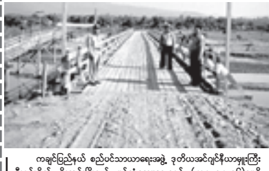
ကချင်ပြည်နယ် စည်ပင်သာယာရေးအဖွဲ့ ဒုတိယအင်ဂျင်နီယာမှူးကြီး ဦးဝင်းဗိုလ် မိုးညှင်းမြို့နယ် ပင်လုံကျေးရွာအဝင် (၂၀၀၁၂၁၀၆)မေရီသစ်သားတံတား တည်ဆောက်ပြီးစီးမှုကို မတ် ၃ ရက်က ကွင်းဆင်းစစ်ဆေးရာ တာဝန်ခံအင်ဂျင်နီယာ ဦးဝင်းဦး ရှင်းလင်းတင်ပြစဉ်။ (မြို့နယ်စည်ပင်)
