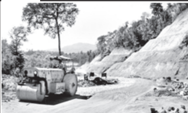
ပျဉ်းမနား-ပင်လောင်းလမ်းတစ်နေရာတွင် လမ်းချဲ့ကျောက်ခင်း လုပ်ငန်းများကို လမ်းကြိုစက်ကြီးဖြင့် ဆောင်ရွက်နေသည်။
