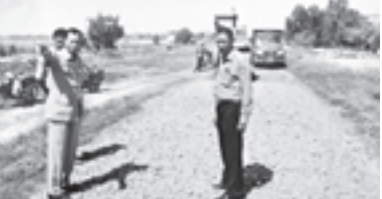
ထန်းတပင်မြို့နယ်၊ အနောက်ပိုင်းကတ္တလွယ်-အေးရွာလမ်း ကမ္ဘာ့ရာလမ်းလုပ်ငန်းဖြင်းလုပ်ငန်းကို မေဇော်ဝါရီ ၁၀ ရက်က အမှဆောင်အရာရှိ ဦးသန်းအောင်နှင့် တာဝန်ခံအင်ဂျင်နီယာ ဦးမျိုးမင်းတို့ ကြီးကြပ်ဆောင်ရွက်စဉ်။ (၁၈၃)
