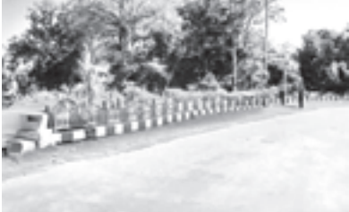
ကသာမြို့နယ် လမ်းမတော်လမ်း လမ်းလယ်ကွန်းတွင် သစ်ပင် အကာတန်းများ ပြုလုပ်ခြင်းကို ဖေဖော်ဝါရီ ၈ရက်က တာဝန်ခံအကူအညီ ဦးစိုးလိမ့်မြင့် ဆောင်ရွက်ရာ မြို့နယ်စည်ပင်သာယာရေးအဖွဲ့ အမှုဆောင်အရာရှိ ဦးထွန်းထွန်း တွင်းဆင်းကြိုကြိုဆောင်ရွက်စဉ်။ (မြို့နယ်စည်ပင်)
