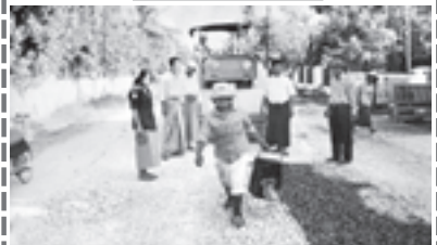
ကြိမ်းမြို့နယ် စည်ပင်သာယာရေးအဖွဲ့က ဗိုလ်ချုပ်လမ်း ကတ္တရာ ထပ်ပိုးပွားခင်းခြင်းလုပ်ငန်း ဆောင်ရွက်နေမှုကို မြို့နယ်ပုဂ္ဂလိက ဦးစီးသန့် ဓမ္မော် ဝါရီ ၁၀ ရက်က ကွင်းဆင်းစစ်ဆေးရာ အမှုဆောင်အရာရှိ ဦးအောင်သက်ရှည် ရှင်းလင်းတင်ပြကြစဉ်။ (မြို့နယ်စည်ပင်)
