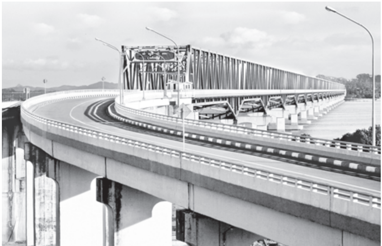
မြန်မာနိုင်ငံ မြောက်နှင့်တောင် လမ်းပန်းဆက်သွယ်မှုကို အရေးပါသည့်အခန်းကဏ္ဍမှ ထိထိရောက်ရောက် ထောက်ကူပံ့ပိုးဖော်ဆောင်ပေးနေသော သံလွင်တံတား (မော်လမြိုင်)။
