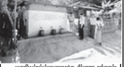
ပခုက္ကူမြို့နယ်စည်ပင်သာယာရေးအဖွဲ့က ချိုင့်ကျေးရွာ စက်ရေတွင်း ရေကန်ရှိ ရေကန် တည်ဆောက်ခြင်းလုပ်ငန်းကို ဇန်နဝါရီ ၁၈ ရက်က အမှ ဆောင်ရွက်ရာရှိ ဦးခိုင်ထွန်းနှင့် အင်ဂျင်နီယာမှူး ဦးစောမျိုးထွန်းတို့ ကွင်းဆင်း စစ်ဆေးရာ လက်ထောက်အင်ဂျင်နီယာ ဦးဇော်လင်းနိုင် ရှင်းလင်းတင်ပြခြင်း။ (၀၇၀)
