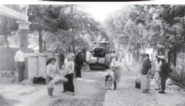
မိတ္ထီလာမြို့နယ်ရှိ စက္ကလမ်း ကတ္တရာခင်းခြင်းလုပ်ငန်းကို ဇန်နဝါရီ ၁၇ ရက်က မြို့နယ်စည်ပင်သာယာရေးအဖွဲ့၊ လက်ထောက်အင်ဂျင်နီယာ ဒေါ်အေးသုစာလှ ကြီးကြပ်ဆောင်ရွက်ခဲ့။ (မြို့နယ်စည်ပင်)
