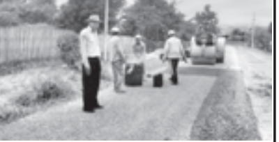
ရှမ်းပြည်နယ် (တောင်ပိုင်း) လင်းခေါမြို့နယ် စည်ပင်သာယာရေးအဖွဲ့က ခိုလှုံချုပ်လမ်း ကတ္တရာခင်းမြင်းလုပ်ငန်း ဆောင်ရွက်နေမှုကို ဇန်နဝါရီ ၁၅ ရက်တွင် တာဝန်ခံအင်ဂျင်နီယာ ဦးပေးမောင် ကြီးကြပ်ဆောင်ရွက်ခဲ့သည်။ (မြန်မာ့စည်ပင်)
