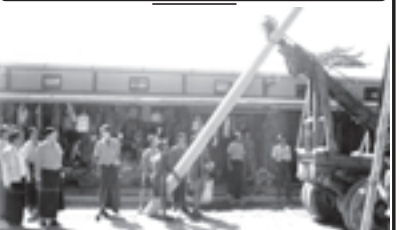
ကမကောင်းမြို့ လျှပ်စစ်ဓာတ်အားလိုင်း တိုးချဲ့ခြင်းနှင့်ကွန်ကရစ်မီးတိုင် စိုက်ထူခြင်းကို ဗဟိုဌာနနှင့် ဥက္ကဋ္ဌ ဦးမောင်ကြီးတို့က ဇန်နဝါရီ ၁၀ ရက်က ကွင်းဆင်းစစ်ဆေးရာ မြန်မာ့အလင်းရုပ်ရှင်စာကြည့်တိုက်နှင့် မြန်မာ့လူ့စစ်ဓာတ်အားလုပ်ငန်း တာဝန်ခံ ဦးမြတ်ကိုကိုတို့ ရှင်းလင်းတင်ပြခဲ့သည်။ (မြန်မာ့စည်ပင်)
