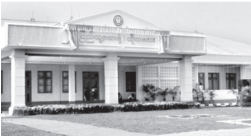
ဘိုကလေးမြို့ရှိ ခုတင်(၁၀၀)ဆံ့ ဆေးရုံသစ်ကြီးကို တွေ့ရစဉ်။
