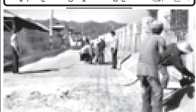
ပင်လုံမြို့နယ် စည်ပင်သာယာရေးအဖွဲ့ ဝန်ထမ်းများ ပြည်ဆောင်ရွက်ရာ ကျောက်တိုင်ပတ်လမ်း ကမ္ဘာ့ရာသီသစ် လုပ်ငန်းဆောင်ရွက်နေမှုကို ဇန်နဝါရီ ၁၇ရက်က မြို့နယ်တာဝန်ခံ ဦးစီးအရာရှိ ဦးသောင်းထွန်းစောနှင့် တာဝန်ခံအင်ဂျင်နီယာတို့ ကွင်းဆင်းကြည့်ရှုစဉ်။ (မြို့နယ်စည်ပင်)
