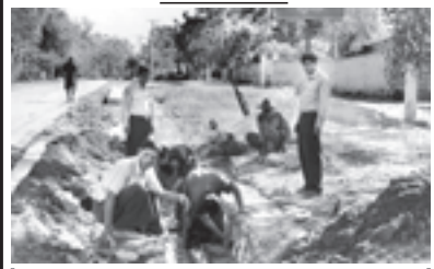
ရန်ခံစံမြို့နယ် စည်ပင်သာယာရေးအဖွဲ့ ဆောင်ရွက်သည့် ခတ္တလမ်း၊ မြောင်းကူးသဲကုက္ကိုက်ရစ်တံတားတည်ဆောက်၊ ငြိမ်းလှုပ်ငုံးကို ဇန်နဝါရီ ၁၀ ရက်က အမှုဆောင်အရာရှိ ဦးမောင်မောင်အေးနှင့် တာဝန်ခံအင်ဂျင်နီယာ ဦးလွင်သက်ပိုင်တို့ ကြီးကြပ်ဆောင်ရွက်စဉ်။ (မြို့နယ်စည်ပင်)
