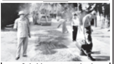
ပခုက္ကူမြို့နယ် စည်ပင်သာယာရေးအဖွဲ့က ကျွတ်ကန်အနားလမ်း ကတ္တရာခင်းမြင်းလုပ်ငန်းကို လက်ထောက်အင်ဂျင်နီယာ ဒေါ်မှီယာဆွေ ဆောင်ရွက်နေခြင်းအား ဇန်နဝါရီ ၆ ရက်က အမှုဆောင်အရာရှိ ဦးတင်ဝင်းနှင့် အင်ဂျင်နီယာမှူး ဦးစောမျိုးတို့က ကွင်းဆင်းကြည့်ရှုစဉ်။ (မြို့နယ်စည်ပင်)
