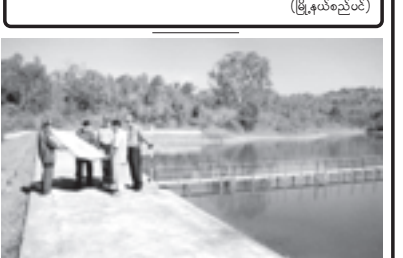
တောင်ကြီးမြို့နယ် စည်ပင်သာယာရေးအဖွဲ့က တီးခင်းတန်းမှ တောင်ကြီးမြို့သို့ ရေပေးစနစ်ကို အထိန်းအကွပ်ရှိစွာ ဦးဆောင်ဆောင်ရွက်နေခြင်းအား ဇန်နဝါရီ ၆ ရက်က အမှုဆောင်အရာရှိ ဦးတင်ဝင်းနှင့် အင်ဂျင်နီယာမှူး ဦးအောင်နိုင်ထွန်းတို့ နေရာက ကွင်းဆင်းကြည့်ရှုစဉ်။ (မြို့နယ်စည်ပင်)
