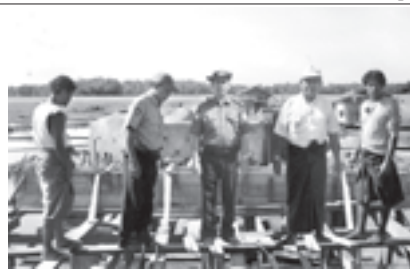
လေးများနှာဖြူနုပွင့် စည်ပင်သာယာရေးအဖွဲ့က ပန်းတောကြီး-ထုံးပေါက်တံတား တည်ဆောက်ရေးလုပ်ငန်းခွင်သို့ ဖြန့်ဖြူးရောင်းချ ဦးကျော်လှဝမ်းဆောင်ရာ အမှုဆောင်အရာရှိ ဦးကျော်ဦးနှင့် တာဝန်ခံအင်ဂျင်နီယာတို့ ရှင်းလင်းတင်ပြစဉ်။ (မြို့နယ်စည်ပင်)
