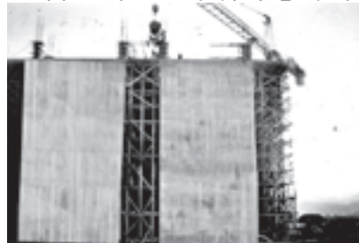
ကြီးအုံကြီးဝရေလှောင်တမံဘက်စုံစီမံကိန်းတွင် Intake အဆောက်အအုံလုပ်ငန်းကို ဤသို့ဆောင်ရွက်ခဲ့ကြသည်။
