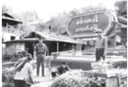
ပလက်ဝမြို့ မြို့ဝင်ဆိုင်းဘုတ်ရွာ၊ မြေယာရှင်းသန့်ဆောင်ရွက်မှုကို စက်တင်ဘာ ၁၇ ရက်က အမှုဆောင်အရာရှိ ဦးမောင်ဝင်းလွင် ကြီးကြပ်ဆောင်ရွက်ခဲ့ပုံ (မြို့နယ်စည်ပင်)
