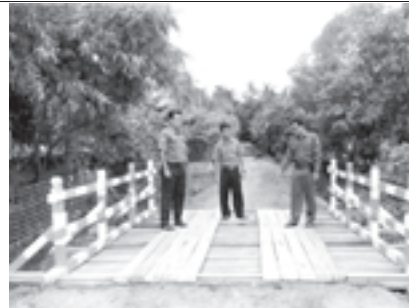
စက်တင်ဘာ ၄ရက်က ရသေ့တောင်မြို့နယ် စည်ပင်သာယာရေးအဖွဲ့၏ ၂၀၁၀-၂၀၁၁ ဘဏ္ဍာနှစ် ရွေးကောက်ပွဲ နှင့်မြို့နယ်အတွင်း ဆောင်ရွက်ခဲ့သော ဘုရားကြီးလမ်း သစ်သားတံတားဆောက်လုပ်ပြီးနောက် အခြေအနေကို မြို့နယ်စည်ပင်သာယာရေးအဖွဲ့ အမှုဆောင်အရာရှိ ဦးမောင်တင်ဦး စစ်ဆေးရာ အထိတန်းအင်ဂျင်နီယာ(၃) ဦးအောင် လွှင့်က ရှင်းလင်းတင်ပြခဲ့ပုံ။ (မြို့နယ်စည်ပင်)
