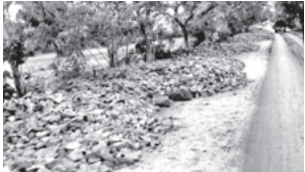
နေပြည်တော် - တောင်ညို - မြို့သစ် - ကန်ပြား(မကွေး)လမ်း၌ လမ်းခင်းရန်အတွက် ကျောက်များ စုစည်းထားစဉ်။
