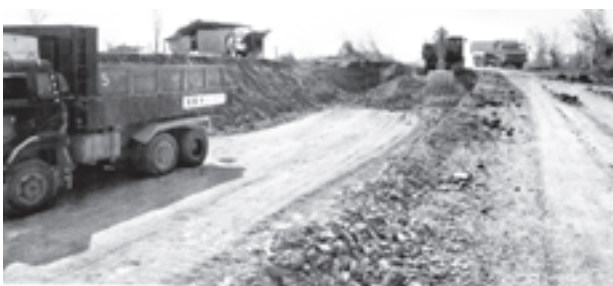
နေပြည်တော်-တောင်ညို-မြို့သစ်-ကန်ပြား(မကွေး)လမ်း၌ ယန္တရားများဖြင့် လမ်းလုပ်ငန်းဆောင်ရွက်စဉ်။
