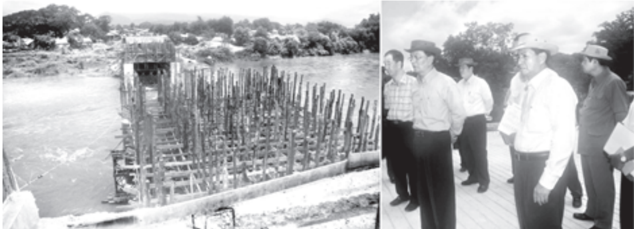
နိုင်ငံတော်ဝန်ကြီးချုပ် ဦးသိန်းစိန် သီပေါတံတား တည်ဆောက်နေမှုကို ကြည့်ရှုစစ်ဆေးစဉ်။ (သတင်းစဉ်)
