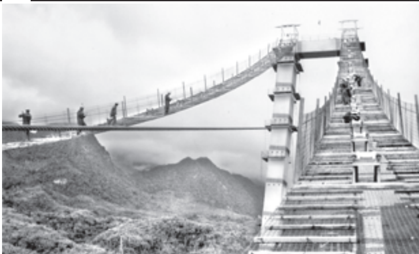
လိန်းလီကြီးတံတားကြီး၏ အဓိကကြီးကြီး တပ်ဆင်ရန် ပြည်သူ့ဆောက်လုပ်ရေးလုပ်ငန်းမှ မြန်မာအင်ဂျင်နီယာများနှင့် လုပ်သားကြီးများ ဆောင်ရွက်နေကြစဉ်။
