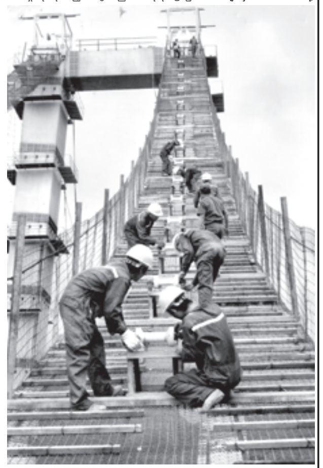
လိန်းလီကြီးတံတားကြီး၏ အဓိကကြိုးကြီးတပ်ဆင်ရန် ပြည်သူ့ဆောက်လုပ်ရေးလုပ်ငန်းမှ မြန်မာအင်ဂျင်နီယာများနှင့် လုပ်သားကြီးများ ဆောင်ရွက်နေကြစဉ်။
