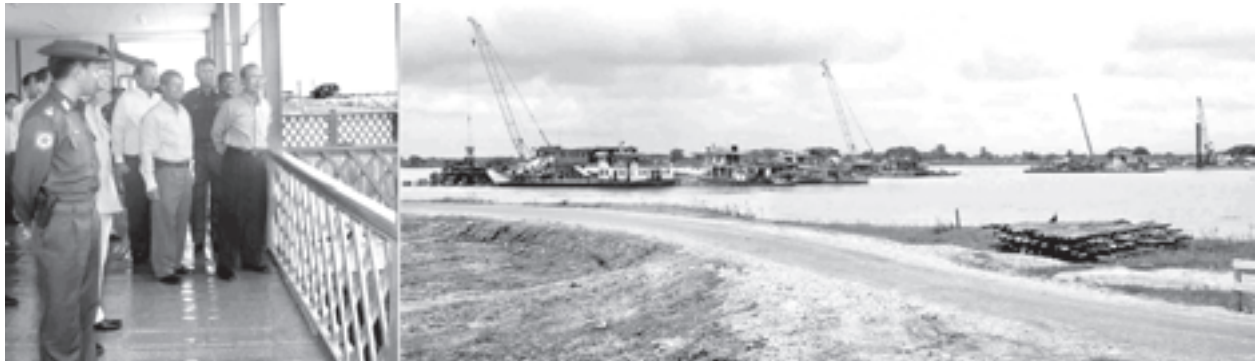
နိုင်ငံတော်ဝန်ကြီးချုပ် ဦးသိန်းစိန် ဧရာဝတီတံတား(ညောင်တုန်း) တည်ဆောက်ရေးစီမံကိန်း ရှင်းလင်းဆောင်ရွက်မှ တံတားတည်ဆောက်နေမှုကို ကြည့်ရှုစစ်ဆေးစဉ်။
