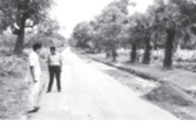
မူကြိုမြို့နယ် စည်ပင်သာယာရေးအဖွဲ့မှ ၂၀၁၀-၂၀၁၁ ဘဏ္ဍာရေးနှစ်အတွင်း ဆောင်ရွက်လျက်ရှိသည့် ကမာတင်ကျေးရွာ ကျွဲတံတားကြီး အဝင်လမ်း ကမာတင် ကျေးရွာ လမ်းခင်းဆောင်ရွက်ပြီးစီးမှုအခြေအနေကို ဇွန် ၁၁ရက်တွင် အမှုဆောင်အရာရှိ ဦးစော်အောင်သန်း ကြည့်ရှုစစ်ဆေးရာ တာဝန်ခံအင်ဂျင်နီယာ ဦးတင်ထွန်းက ရှင်းလင်း တင်ပြခဲ့။ (မြို့နယ်စည်ပင်)
