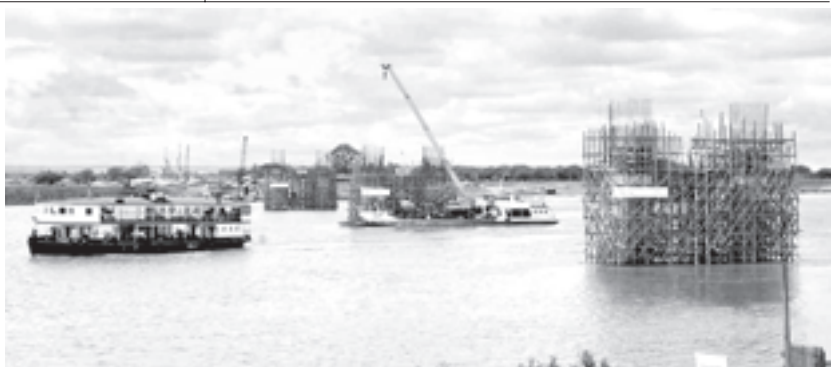
မကွေးတိုင်း ပခုက္ကူမြို့နယ် ပခုက္ကူဘက်ကမ်းရှိ ရေလယ်တိုင်များကို ပြည်သူ့ဆောက်လုပ်ရေးလုပ်ငန်းက နေ့မအား ညမအား တည်ဆောက် လျက်ရှိသည့်မြင်ကွင်းကလည်း အားတက်ဖွယ်ရာ....။
