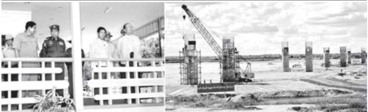
နိုင်ငံတော်ဝန်ကြီးချုပ် ဦးသိန်းစိန် ဧရာဝတီတံတား(ပခုက္ကူ) တည်ဆောက်ရေးစီမံကိန်း ရှင်းလင်းဆောင်ရွက်ရာမှ ဧရာဝတီမြစ်အတွင်းနှင့် ကမ်းနှစ်ဖက်တို့၌ စီမံကိန်းလုပ်ငန်းများ ဆောင်ရွက်နေမှုကို ကြည့်ရှု စစ်ဆေးစဉ်။
