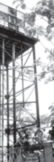
ညောင်လေးပင်မြို့တွင် သောက်သုံးရေ ရရှိရေးအတွက် အမြင့် ၆၅ မေရှိ ရေဂါလန် ၃၀၀၀၀ ဆံ့ ရေစင်ကို ဤသို့တည်ဆောက်ထားသည်။
