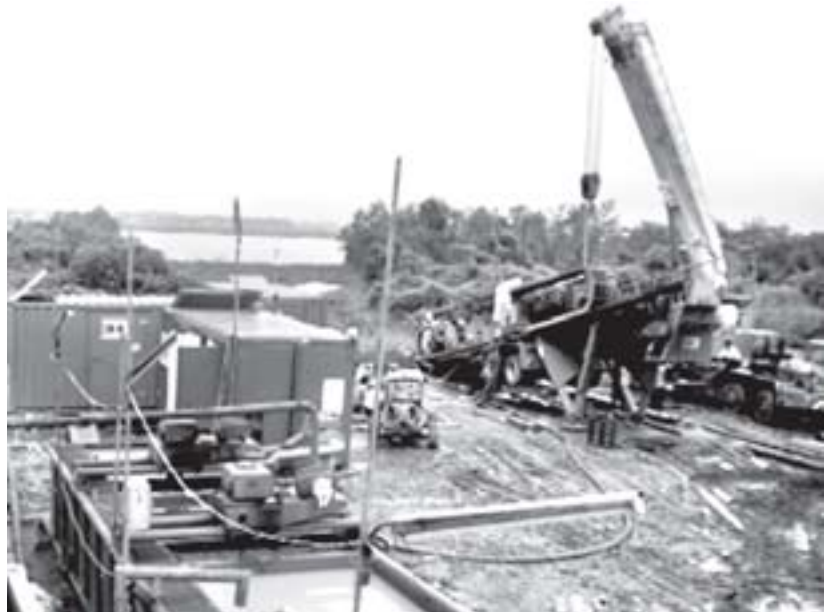
HDD (Horizontal Directional Drilling Machine) စက်ဖြင့် မြစ်ကြမ်းခင်းအောက်မှ တူးဖောက်ရေးလုပ်ငန်း ဆောင်ရွက်နေစဉ်။
