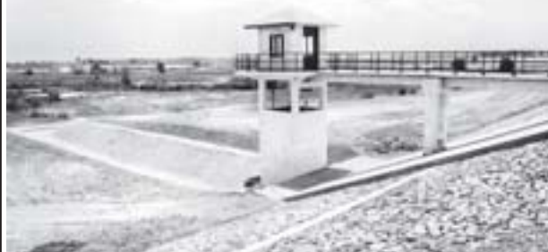
ရေဘုတ်ရေလှောင်တံခံရှိ တည်ဆောက်ပြီးစီးနေသော ရေထုတ်မြန်နှင့် ရေထုတ်မြောင်း။
