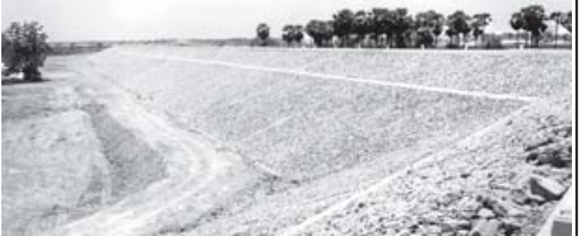
အလျား ပေ ၁၇၇၂၀ (သုံးမိုင်ကျော်) အမြင့် ၄၆ပေရှိ ရေဘုတ်ရေလှောင်တံခံ၏ ပင်မတံခံတည်ဆောက်ပြီးစီးမှုဖြစ်ကြောင်း။
