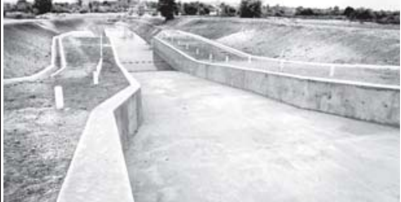
ကရင်ပြည်နယ် လှိုင်းဘွဲ့မြို့နယ် ရေဘုတ်ရေလှောင်တံခံ၏ သံကွက်ကုန်အမျိုးအစား ရေပိုလွှဲတည်ဆောက်ပြီးစီးမှုအဆုတ်အတွက်...
