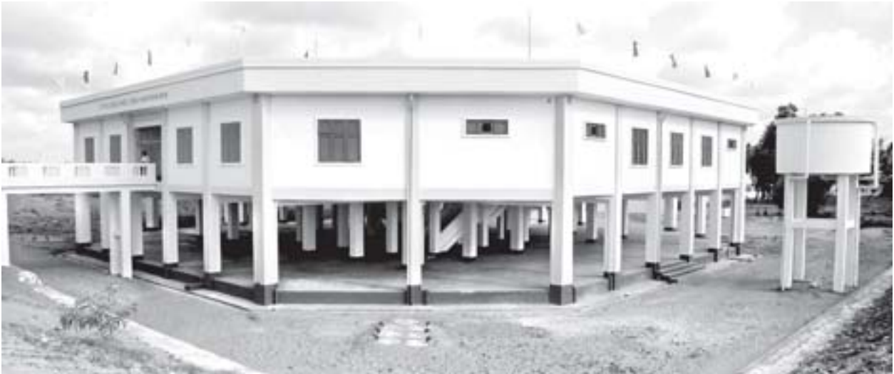
ဘိုကလေးမြို့နယ် ကဒုံကန်ကျေးရွာရှိ လူ(၅၀၀)ခန့်လွှဲနိုင်သည့် Cyclone Shelter ကို တွေ့ရစဉ်။
