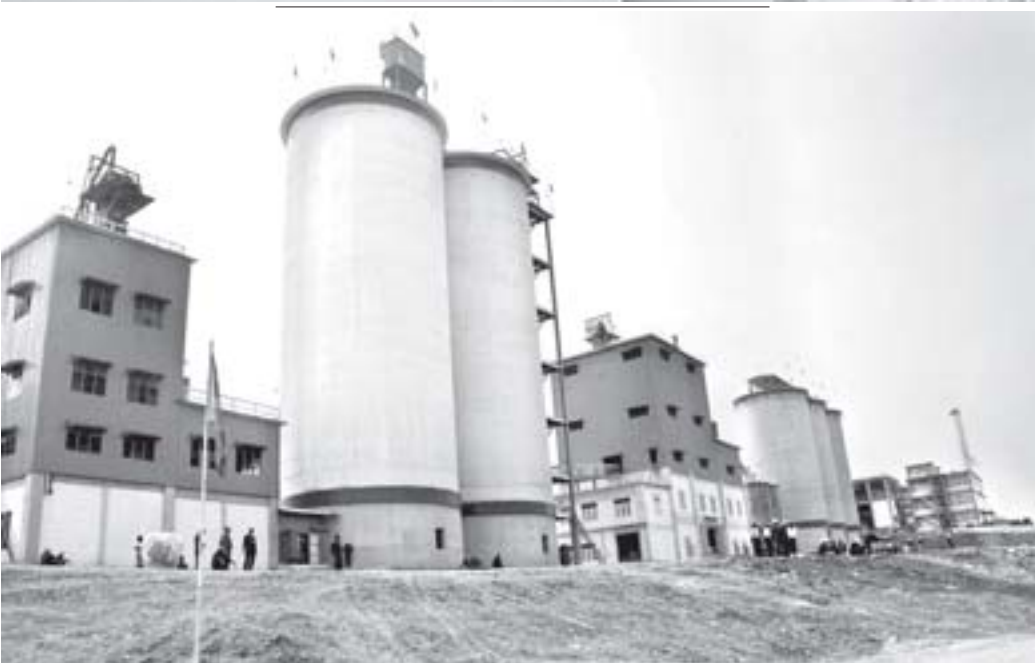
ရန်ကုန်မြို့တော် စည်ပင်သာယာရေးကော်မတီ၏ မြို့တော်ဘိလပ်မြေစက်ရုံကို တွေ့ရစဉ်။ (သတင်းစဉ်)
