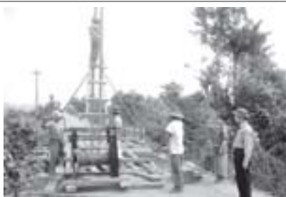
ကျေးလင်းမြို့နှင့် တောင်မော်ကျေးရွာ ဆက်သွယ်သောလမ်းပေါ်ရှိ အရှည် ၄၇ပေ၊ အကျယ် ၂၅ပေရှိ သစ်သားတံတားဆောက်လုပ်မှုကို မြို့နယ်စည်ပင် သာယာရေးအဖွဲ့မှ အလယ်တန်းအင်ဂျင်နီယာ(၂) ဒေါ်မောင်အောင်နှင့် အမှုဆောင်အရာရှိ ဦးတင်အောင်တို့ ကြီးကြပ်ဆောင်ရွက်ကြသည်။ (မြို့နယ်စည်ပင်)
