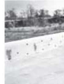
ဝန်ယူတံ၏ အကျယ်ပေ ၄၀ရှိ ကျောက်စိ ကွန်ကရစ်အမျိုးအစား ပင်မ ရေပိုလွှတ် ဤသို့ တွေ့ရသည်။ ဓာတ်ပုံမှတ်တမ်း - အောင်သန်း(မင်္ဂလာတောင်ညွန့်)
