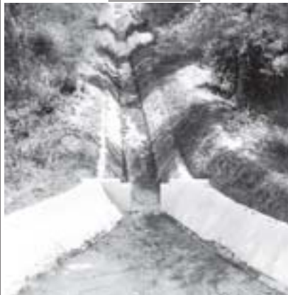
ဝန်ယူတံ၏ လယ်မြေ ၃၄၅ဧကသို့ ရေထုတ်လွှတ်ပေးမည့် အလျား ပေ ၁၂၀၀၀ရှိ ရေပေးတူးမြောင်းကို တွေ့ရစဉ်။ ဓာတ်ပုံမှတ်တမ်း - အောင်သန်း(မင်္ဂလာတောင်ညွန့်)
