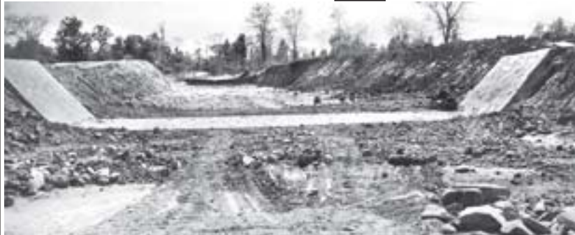
ဝန်ယူရေလောင်းတံ၏ အရေပေါ် ရေပိုလွှတ် တွေ့ရပုံ။ ဓာတ်ပုံမှတ်တမ်း - အောင်သန်း(မင်္ဂလာတောင်ညွန့်)
