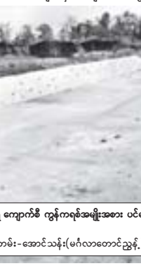
ဝန်ယူတံ၏ အကျယ်ပေ ၄၀ရှိ ကျောက်စိ ကွန်ကရစ်အမျိုးအစား ပင်မ ရေပိုလွှတ် ဤသို့ တွေ့ရသည်။ ဓာတ်ပုံမှတ်တမ်း - အောင်သန်း(မင်္ဂလာတောင်ညွန့်)
