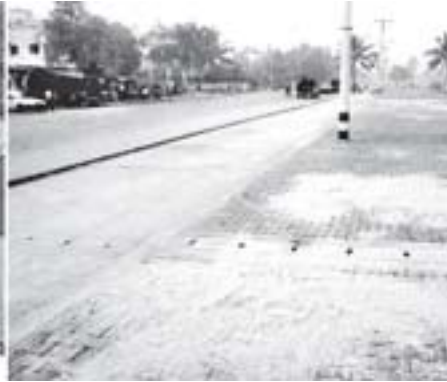
နိုင်ငံတော် ဝန်ကြီးချုပ် ဗိုလ်ချုပ်ကြီး ချမ်းအေးသန်းမြို့နယ် ပါးလမ်းရှိ မော်ရမယ် နှင့် ကျန်းမာရေးလေ့ကျင့်ရန် ကိရိယာများအသုံး ကုန်ကရိယာလက်တိုးခင်းခြင်းလုပ်ငန်း ဆောင် ရွက်နေစဉ်။
