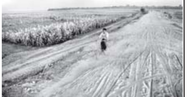
တာပေါင်အမြင့် ၁၀ပေရှိ မြေသားတာပေါင်ဖြစ်သည်။ တမာ တန်းလမ်းဆုံနှင့် ရေစကြိုမြို့နယ်ကို ဆက်သွယ်သော တာပေါင်ပြုလုပ်ထား သည်။ ချင်းတွင်းမြစ်ရေကျချိန်ဖြစ်၍ တာပေါင်တစ်ဖက်တွင် မြေတူးသီးနှံ များ ကွင်းလုံးပြည့် စိုက်ပျိုးထားခြင်း
