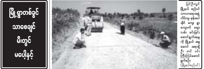
ပြင်ဦးလွင် မြို့နယ် စည်ပင် သာယာရေးအဖွဲ့ လိပ်ကျ-ရန်ပေါ အိုင် ကျေး ရွာ ကျောက် ရော လမ်း ခင်းခြင်း ဆောင်ရွက်နေမှု ကို မြို့နယ် အမှု ဆောင် အရာရှိ ဦး တင် ဝင်း ကြီးကြပ်ဆောင် ရွက်စဉ်။ (မြို့နယ်စည်ပင်)
