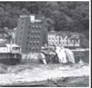
တရုတ်(တိုင်ပေ)သို့ မိုရောကုန်တိုင်း ဝင်ရောက်တိုက်ခတ်ပြီးနောက် အဆောက်အအုံများ ဤသို့ ပျက်စီးခဲ့ရသည်။
