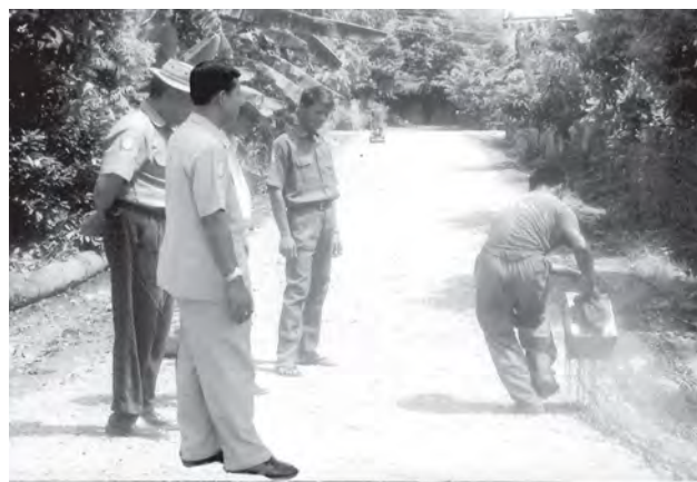
ငမဲမြို့နယ် စည်ပင်သာယာရေးအဖွဲ့ ဆောင်ရွက်သော ငမဲမြို့ မင်းရဲကျော်စွာလမ်း ကတ္တရာခင်းခြင်းလုပ်ငန်းဆောင်ရွက်မှုကို မကွေးတိုင်း စည်ပင်သာယာရေးအဖွဲ့ ညွှန်ကြားရေးမှူး ဦးဆန်းမော်ခင် ကွင်းဆင်းစစ်ဆေးရာ အမှုဆောင်အရာရှိ ဦးသိန်းဌေးက လုပ်ငန်းဆောင်ရွက်မှုအခြေအနေကို ရှင်းလင်းတင်ပြစဉ်။ (မြို့နယ်စည်ပင်)
