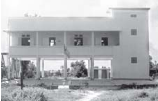
နှစ်ထပ် RC ကျေးရွာမူလတန်းကျောင်း တစ်ကျောင်းကိုတွေ့ရစဉ်။
