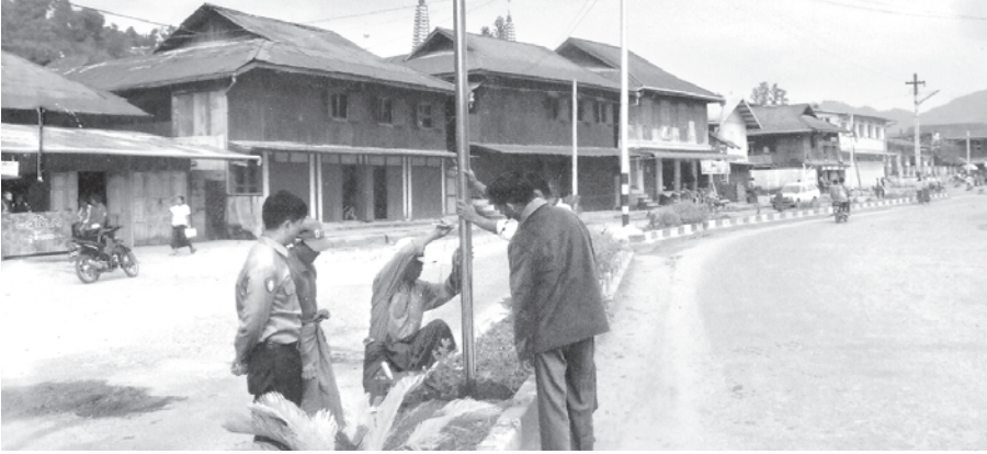
မိုးကုတ်မြို့နယ် စည်ပင်သာယာရေးအဖွဲ့၏ မြို့သာယာလှပရေးလုပ်ငန်းဖြစ်သော လမ်းမီးချောင်း၊ မီးဆိုင်များ တပ်ဆင်ခြင်းလုပ်ငန်းကို လက်ထောက်အင်ဂျင်နီယာ ဦးသန်းတန်က တာဝန်ယူဆောင်ရွက်လျက်ရှိရာ အမှုဆောင် အရာရှိ ဦးပြည်စိုး ကွင်းဆင်းစစ်ဆေးစဉ်။ (မြို့နယ်စည်ပင်)
