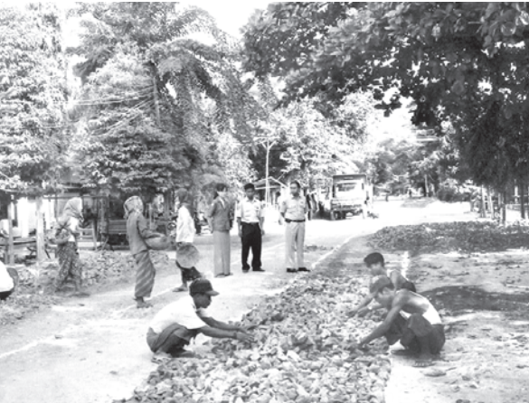
မကွေးမြို့နယ် စည်ပင်သာယာရေးအဖွဲ့ ၂၀၀၉-၂၀၁၀ ဘဏ္ဍာရေးနှစ်တွင် ဆောင်ရွက်သော ၁၇လမ်း၊ ပြည်တော်သာလမ်းနှင့် မဲလီးလမ်းကြား ကမ္ဘာ့ရာထပ်ပိုးလွှာ ခင်းခြင်း လုပ်ငန်းဆောင်ရွက်မှုကို အမှုဆောင်အရာရှိ ဦးသက်ထွန်းနှင့် အငယ်တန်း အင်ဂျင်နီယာ(၂) ဒေါ်သီရိတို့ကို ကွင်းဆင်းကြီးကြပ် ဆောင်ရွက်စဉ်။ (မြို့နယ်စည်ပင်)
