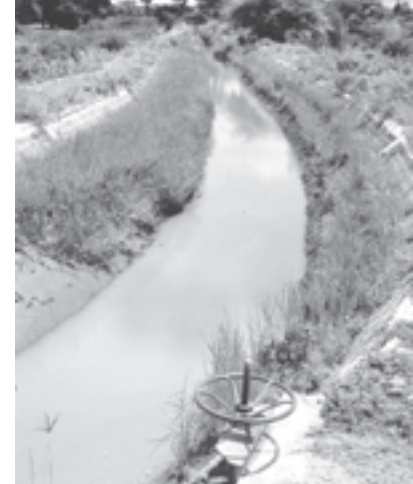
ဥမင်ကိုးပေါက်မြစ်ရေတင်စီမံကိန်း ပင်မမြောင်းကြီးမှရေကို အကျယ် ငါးပေါ်အမှတ် လေးပေါ် အချဉ်ပေါ် ၆၈၇၀၀ရှိ လက်ကံမြောင်းများမှတစ်ဆင့် လယ်မြေများဆီသို့ ဤသို့ ထုတ်လွှတ်ပေးသည်။ (မြန်မာ့အသံ)
