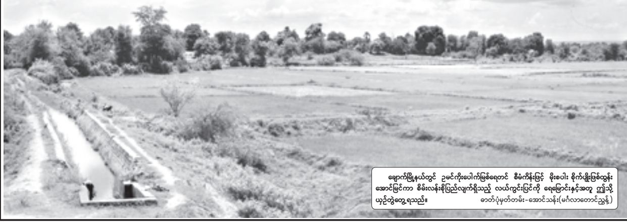
ဥမင်ကိုးပေါက်မြစ်ရေတင်စီမံကိန်း ပင်မမြောင်းကြီးမှရေကို အကျယ် ငါးပေါ်အမှတ် လေးပေါ် အချဉ်ပေါ် ၆၈၇၀၀ရှိ လက်ကံမြောင်းများမှတစ်ဆင့် လယ်မြေများဆီသို့ ဤသို့ ထုတ်လွှတ်ပေးသည်။ (မြန်မာ့အသံ)
