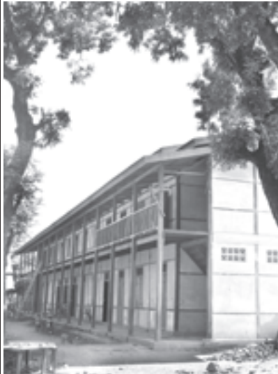
နေပြည်တော်တပ်ကုန်းရှိ အမှတ်(၁) အခြေခံပညာ အထက်တန်းကျောင်း ၏ နှစ်ထပ်ကျောင်းဆောင်သစ်ကြီးကို ဤသို့တွေ့ရသည်။ (မြန်မာ့အသံ)
