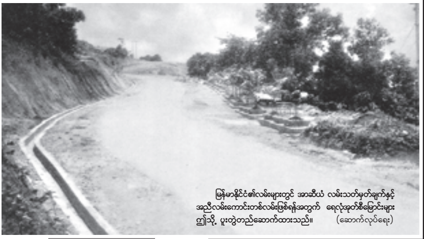
အာဆီယံလမ်းသတ်မှတ်ချက် အမျိုးအစား၌ ပါဝင်သည့် ဘီလပ်မြေကွန်ကရစ်အဆင့်မြင့်လမ်းကို ရန်ကုန်-မန္တလေး အမြန်လမ်းမကြီး နေပြည်တော်-ရန်ကုန်လမ်းပိုင်းတွင် ခင်းထားသည်ကို ဤသို့တွေ့ရသည်။ (ဆောက်လုပ်ရေး)
