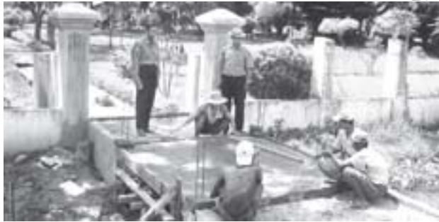
အင်္ဂလိပ်နိုင်ငံသို့ စည်ပင်သာယာရေးအဖွဲ့ ၂၀၀၉-၂၀၁၀ ဘဏ္ဍာရေးနှစ် သာမန်လုပ်ငန်းဖြစ်သော ဖန်နီအောင်လမ်း ကွန်ကရစ် တံတား တည်ဆောက်မှုကို အောက်တိုဘာ ၁၂ရက်က အမှုဆောင်အရာရှိ ဦးခင်မောင်ဦးနှင့် လက်ထောက်အင်ဂျင်နီယာ ဦးတင်မောင်ဦးတို့ ကြိုကြည့်ဆောင်ရွက်ခဲ့ကြသည်။ (မြို့နယ်စည်ပင်)
