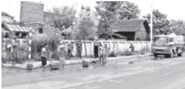
မင်းကင်းမြို့နယ် စည်ပင်သာယာရေးအဖွဲ့မှဆောင်ရွက်သော သောင်ကုန်းကျေးရွာ စက်ရေတွင်းတူးဖော်ခြင်းကို အမှုဆောင်အရာရှိ ဦးကျော်ထင်မောင်မောင်နှင့် တာဝန်ခံအင်ဂျင်နီယာ ဦးမြင့်အောင်တို့ ကြိုကြည့်ဆောင်ရွက်စဉ်။ (မြို့နယ်စည်ပင်)
