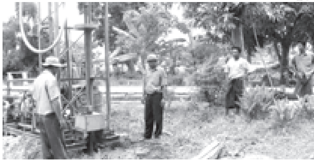
မင်းကင်းမြို့နယ် စည်ပင်သာယာရေးအဖွဲ့မှဆောင်ရွက်သော သောင်ကုန်းကျေးရွာ စက်ရေတွင်းတူးဖော်ခြင်းကို အမှုဆောင်အရာရှိ ဦးကျော်ထင်မောင်မောင်နှင့် တာဝန်ခံအင်ဂျင်နီယာ ဦးမြင့်အောင်တို့ ကြိုကြည့်ဆောင်ရွက်စဉ်။ (မြို့နယ်စည်ပင်)
