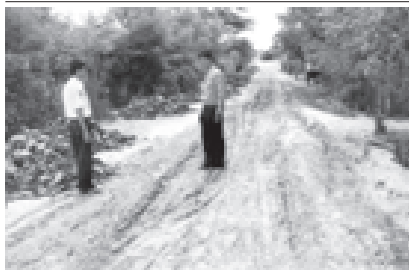
ပါးစုံမြို့နယ် ကျောက်တလုံး-လက်ဝဲစင်လမ်း ကျောက်ချောင်းခြား လုပ်ငန်းခွင်၌ လမ်းခင်းကျောက် စုဆောင်းပြီးနောက်မြေအေးအေးကို ဇွန် ၂၇ ရက်က အမှုဆောင်အရာရှိ ဦးဝင်းစိုးလှ ကျင်းပသောစဉ်ကူးမြို့နယ် (မြို့နယ်စည်ပင်)
