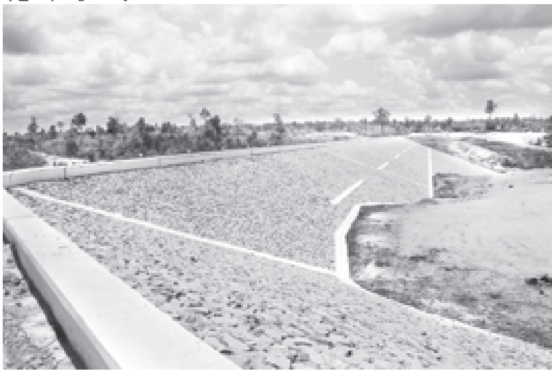
အလျား ၁၇၀၂ပေ၊ အမြင့်ပေ ၂၀ရှိ မဒန်းရေလျှောင်တံခံ၏ ကုန်းကြော တံခံ တည်ဆောက်ပြီးနောက် အနေအထား။ (မြန်မာ့အလင်း)
