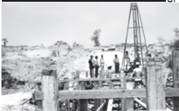
မုံရွာမြို့နယ်စည်ပင်သာယာရေးအဖွဲ့၊ ဆောင်ရွက်လျက်ရှိသည့် စောစောတစ်ထောင် ကျောက်စာရုံအား ဖွင့်လှစ်လမ်း လှည့်ကျေး နေရာသစ်သစ်တော်တော် တည်ဆောက်မှုကို ဧပြီ ၂၇ရက်က အမှုဆောင်အရာရှိ ဦးမြတ်စိုးနှင့် အင်ဂျင်နီယာမှူး ဦးသင်းမင်းလတ်တို့ တွင်းဆင်းကြည့်ကြည့်စဉ်။
