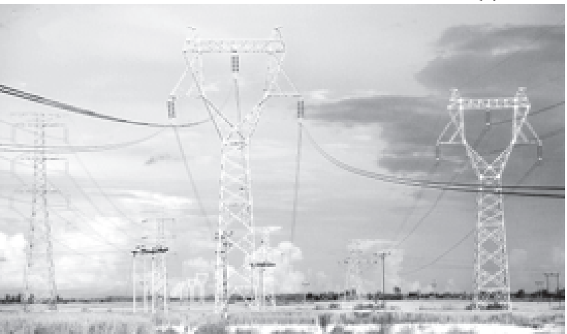
အမှတ်(၂) လျှပ်စစ်စွမ်းအားဝန်ကြီးဌာန မြန်မာ့လျှပ်စစ်ဓာတ်အားလုပ်ငန်း ဓာတ်အားပို့လွှတ်ရေးစီမံကိန်း(တောင်ပိုင်း)မှ တာဝါနံယုတည်ဆောက်ခဲ့သော ကမာနုတ်-မြောင်းတကာ ၂၃၀ကေဗီ မဟာဓာတ်အားလိုင်းကို ဤသို့တွေ့ရသည်။ (ဓာတ်ပုံမှတ်တမ်း-မြန်မာ့အလင်း)
